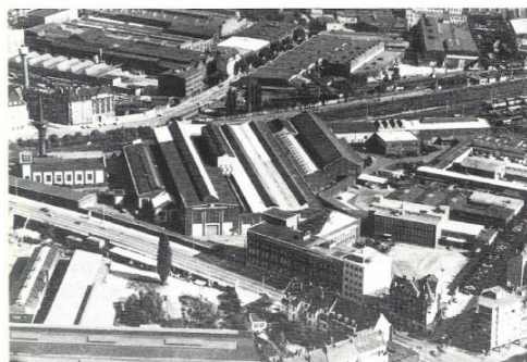
Verein Kesselwerke A.G., Düsseldorf-Oberbilk (um 1970). (Das alte Kesselhaus Mitte links, die Werkshallen, rechts unten Verwaltungsgebäude). Foto: Werksarchiv.
